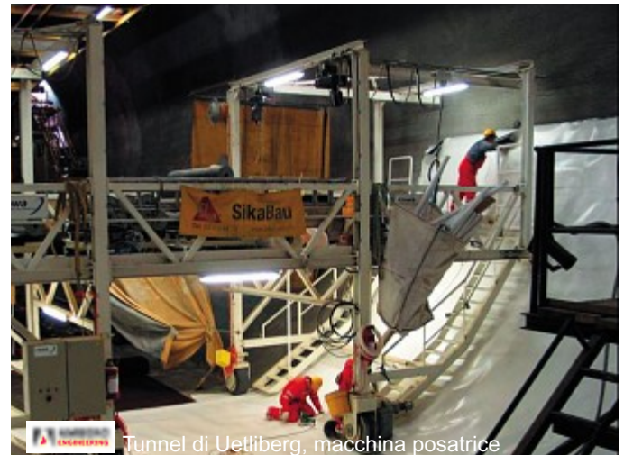
Tunnel di Uetliberg, macchina posatrice
