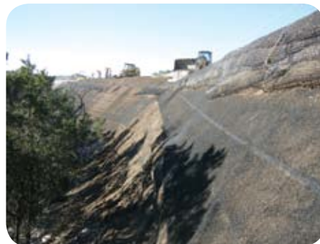
San Antonio USA, beim Einbau
