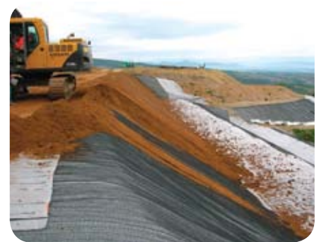
Deponieabdeckung Enkamat 7010W/200.50 PET Enkadrain 5006H/T110PP Forcalquier, Frankreich
