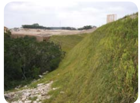
San Antonio USA, nach dem Einbau
