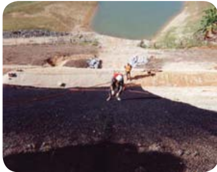
Böschungsschutz Enkamat 7018 New South Wales, Australien
