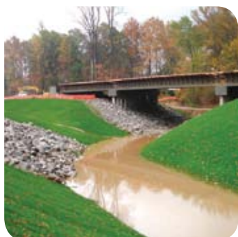
Memphis USA, fertiger Zustand
