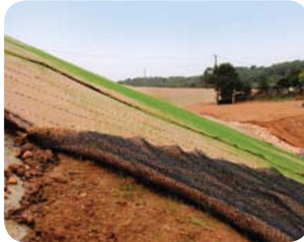
Deichschutz gegen Hochwasser Enkamat J Vauvert, Frankreich
