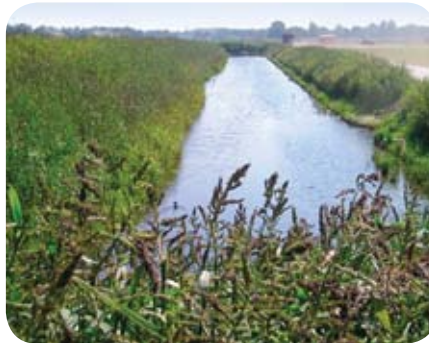
Schutz der Flussuferböschung Enkamat A20 Vathorst, Niederlande
