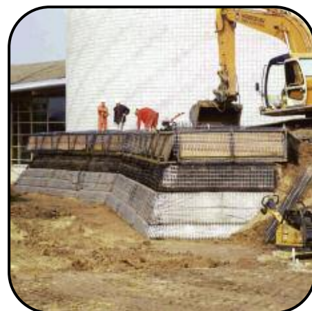
Emmen, Niederlande: Steilwand unter Verwendung von Enkagrid PRO and Enkamät 7210
