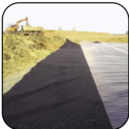
Ungarn, Autobahn Görbehaza Strassenbau mit Enkagrid MAX 30
