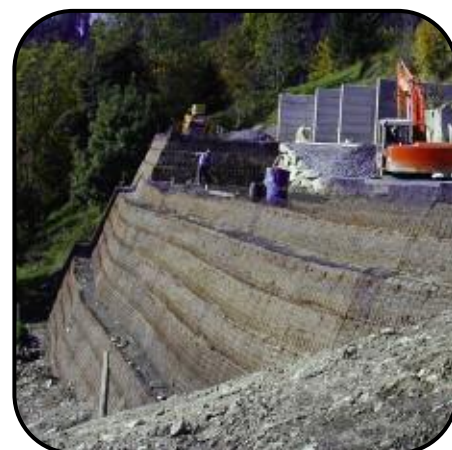
Verbier, Schweiz: Rückverhängte Gabionenwand mit Enkagrid PRO 40
