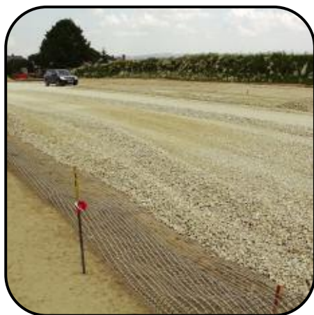
Żywiec, Polen: Tragschichtbewehrung mit Enkagrid MAX
