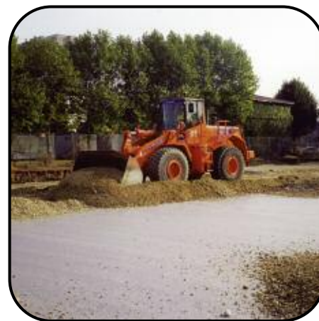
Lyon, Frankreich: Tragschichtbewehrung bei Parkflächen (Enkagrid TRC 30)
