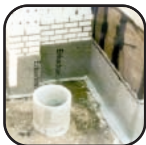
Mur de soubassement
