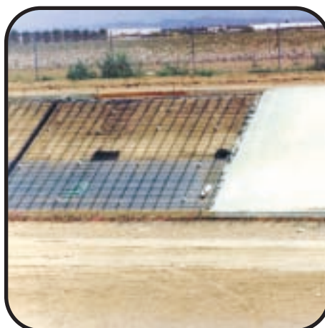
Phoenix, Arizona Couche de drainage des eaux
