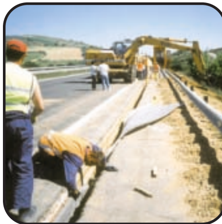
Autoroute, Espagne Drainage de rive de chaussée
