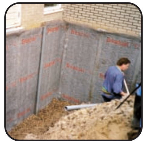
Haren, Pays-Bas Mur de soubassement
