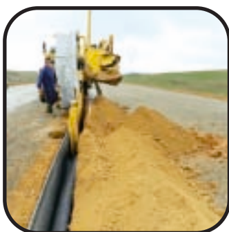
A29, France Drainage de rive de chaussée
