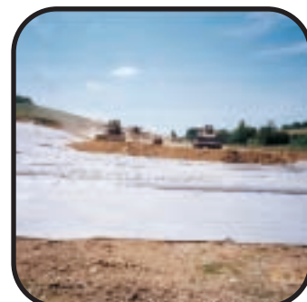
Auch, France Base drainante sous remblai
