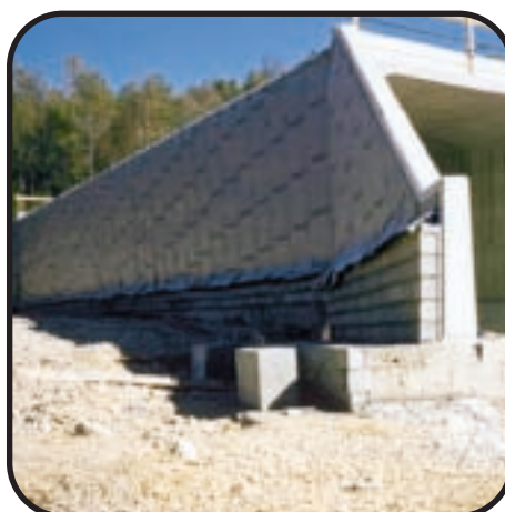
France Tranchée couverte
