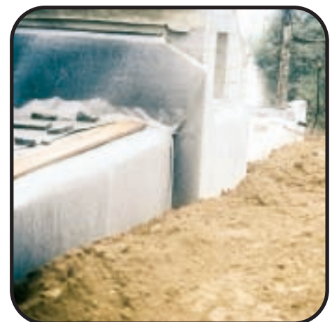
Tübingen, Allemagne Mur de soubassement
