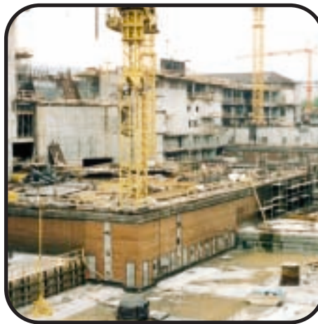
Stuttgart, Allemagne Coffrage perdu
