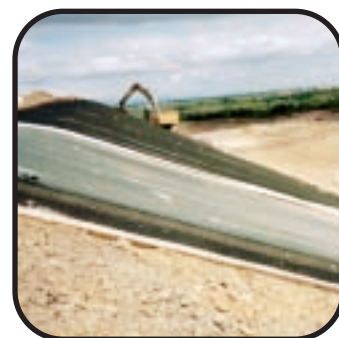
Béziers, France - drainage des lixiviats avec accroche de terre - drainage des biogaz
